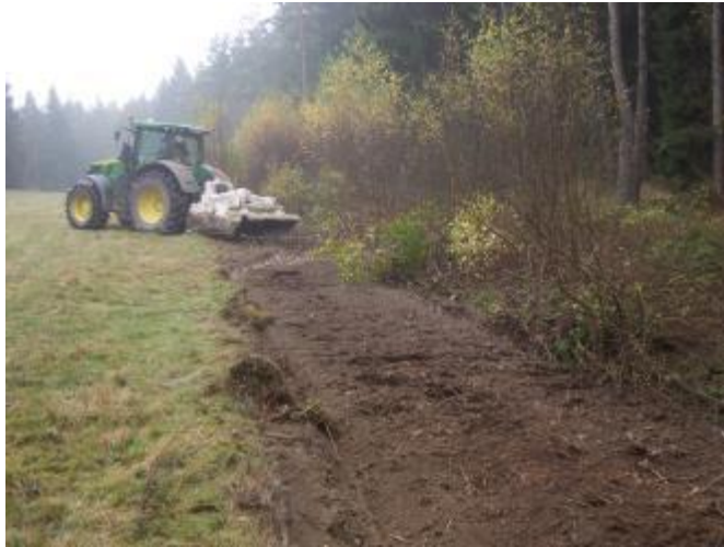
Abb. 18: Mit der Baufräse am Schlepper wird die Habitatfläche Tiefenbrunn erweitert und von starker, die Fläche bedrängender Gehölzsukzession befreit (Foto: T. Findeis)
